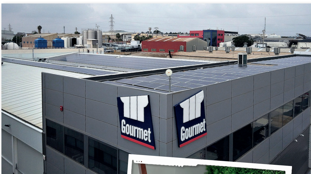
Instalaciones de autoconsumo en la química Iberchem (foto superior) en Alcantarilla (Murcia), con 234 kWp de potencia. Y en la cárnica Gourmet, en Paterna (Valencia), con 362 kWp. A la derecha, Luis Navarro, gerente de Cubierta Solar. En la página anterior, autoconsumo de 2,77 MWp en la compañía textil TexAthenea, en Villena (Alicante)
