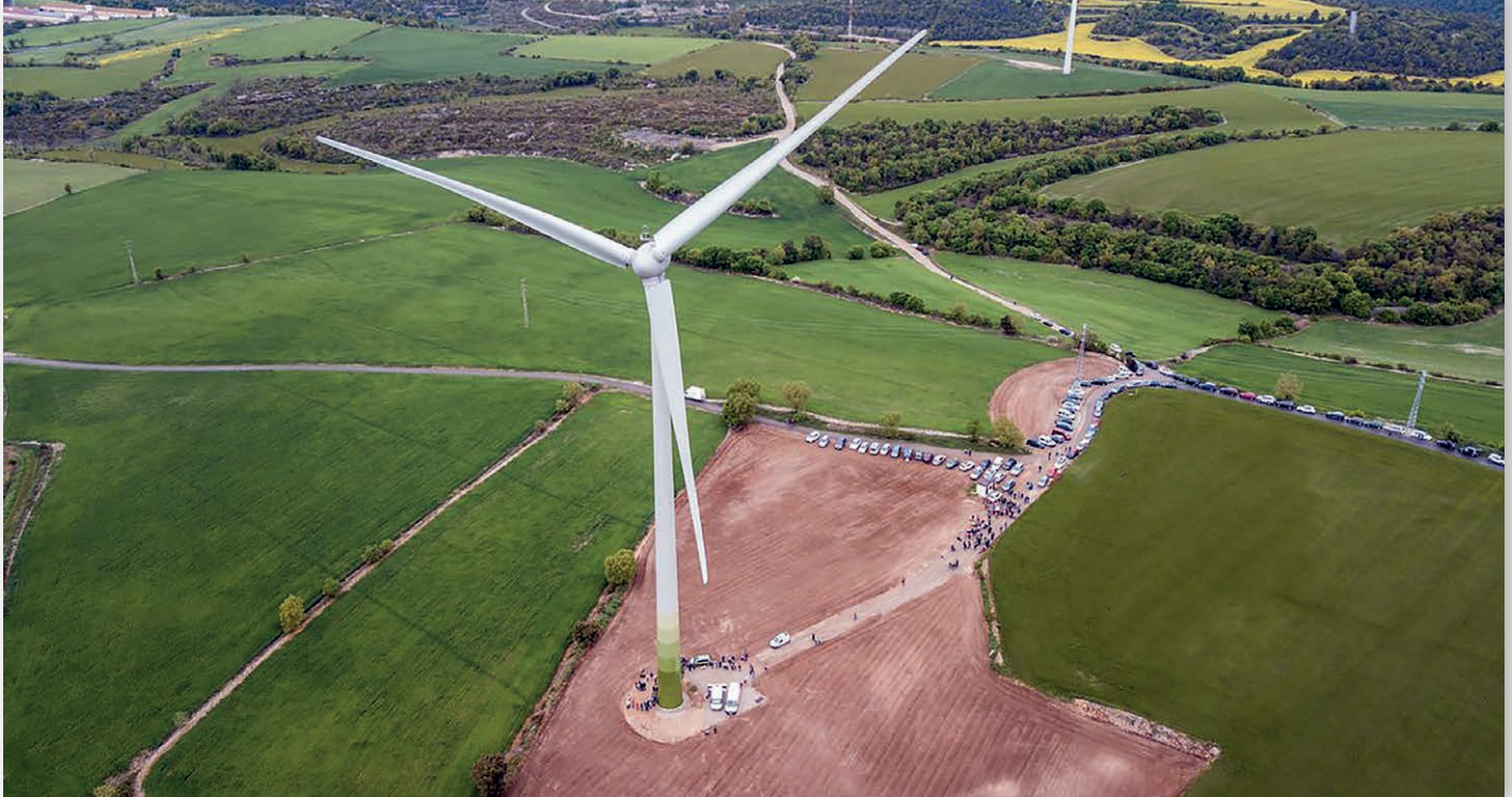
Este es el aerogenerador Enercon de 2,3 MW que el proyecto Viure de l'Aire del Cel instaló en Pujalt (Alta Anoia, Barcelona). Está en operación desde 2018.
