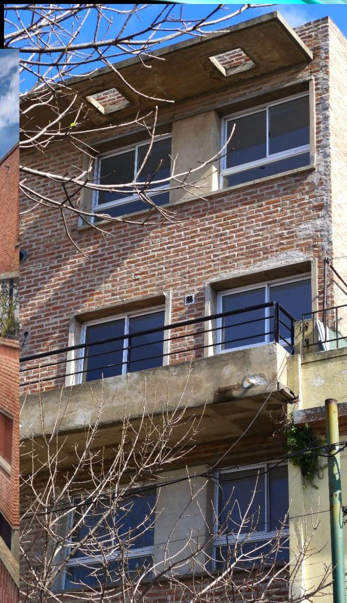
Coop. Emergencias. Barracas.
